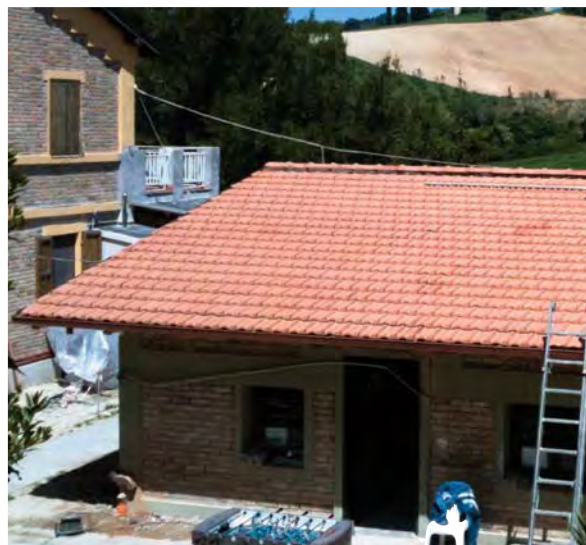
Completata la sostituzione del vecchio tetto con una nuova copertura
