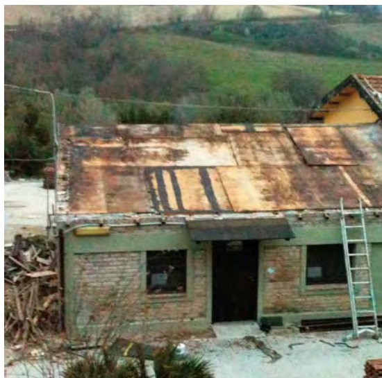
Vecchio tetto in fase di restauro
