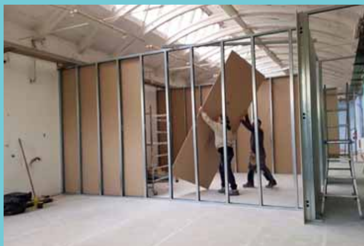
I lavori in corso per realizzare i laboratori
